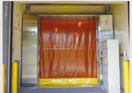
屋内二枚目扉前設置パターン シートシャッターとの連動：プルスイッチ式
