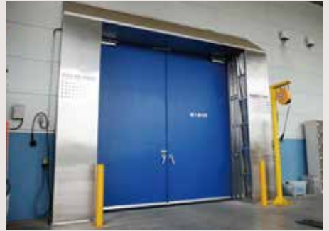
屋外側設置パターン 観音扉との連動：ボタンスイッチ運転式
